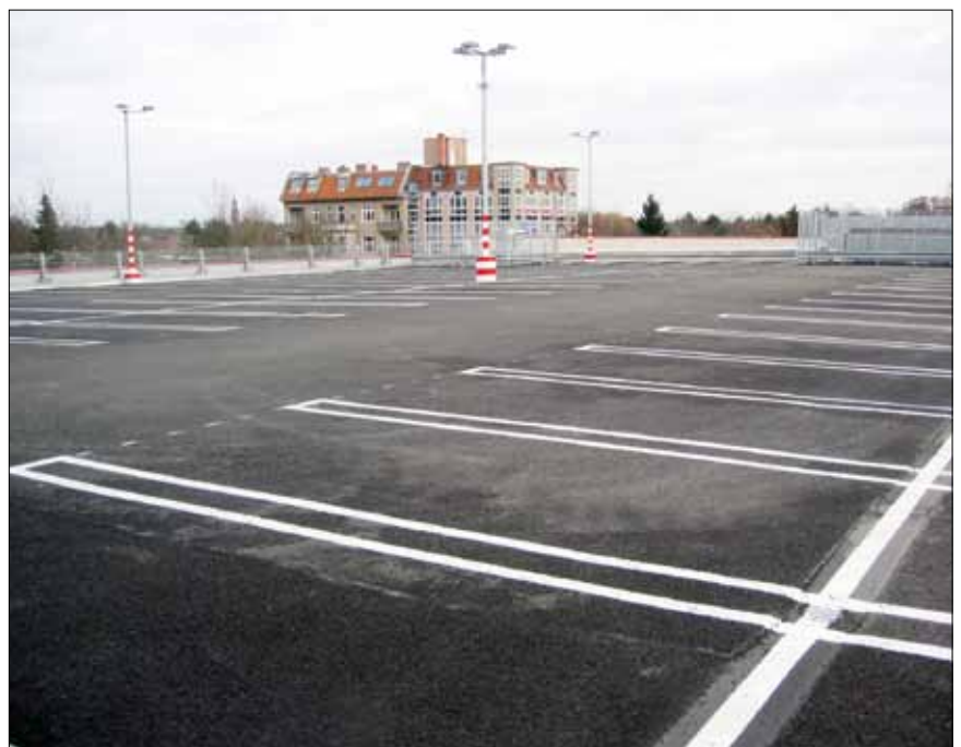
Abb. 2: Eine Parkfläche nach der Sanierung.
