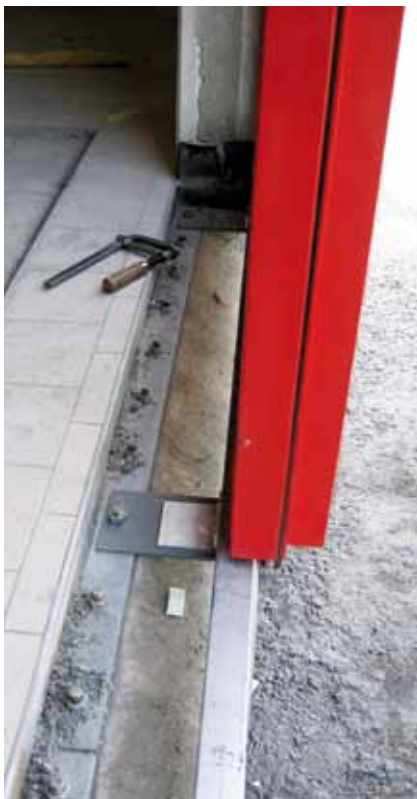
Abb. 3: Vorbildlicher Türanschluss.
